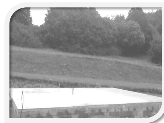
Príklad realizácie základov RD Stilo 3i
