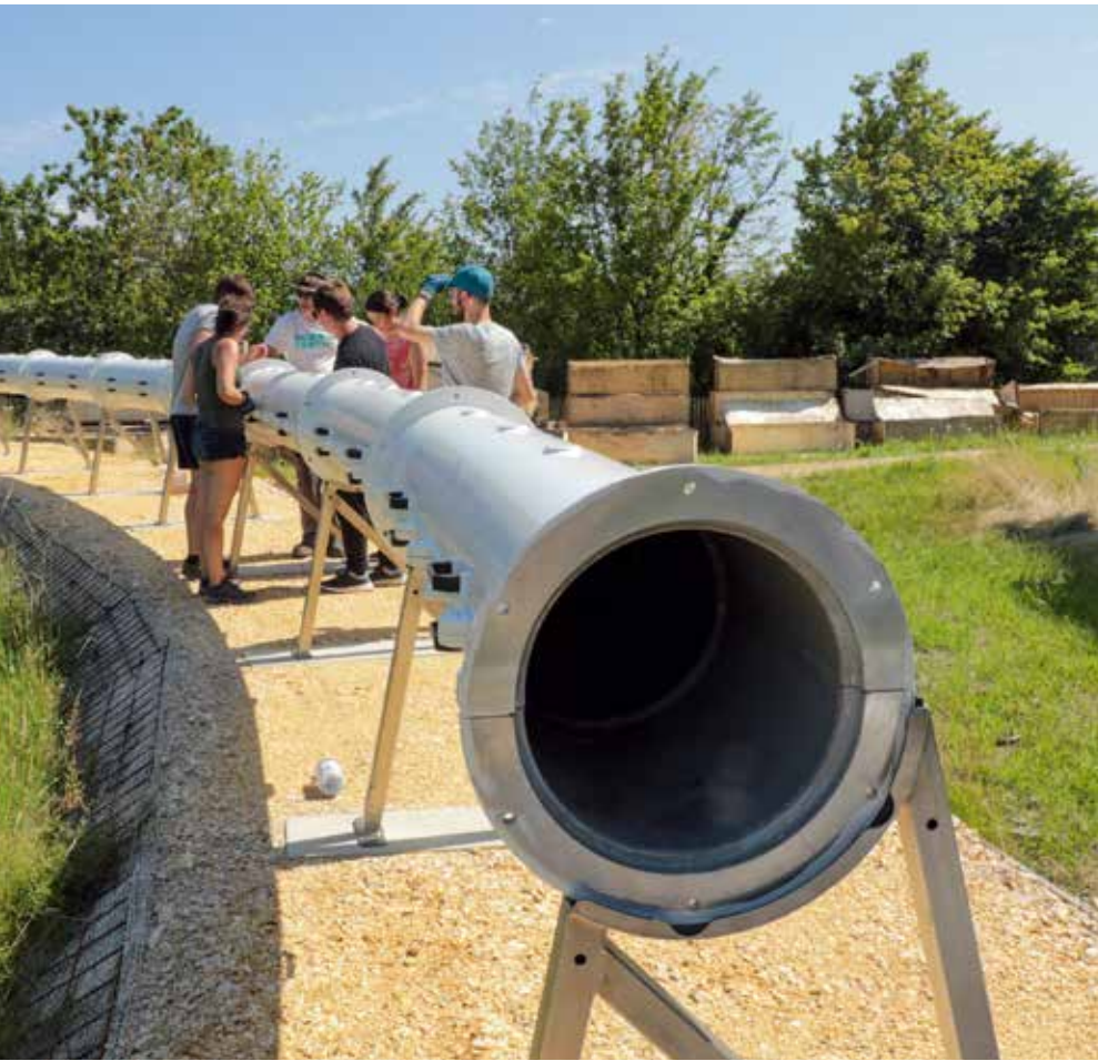
▲ 装配中。装配完成后,管道(按 1:12 比例设计)的直径将达到 40 米。
