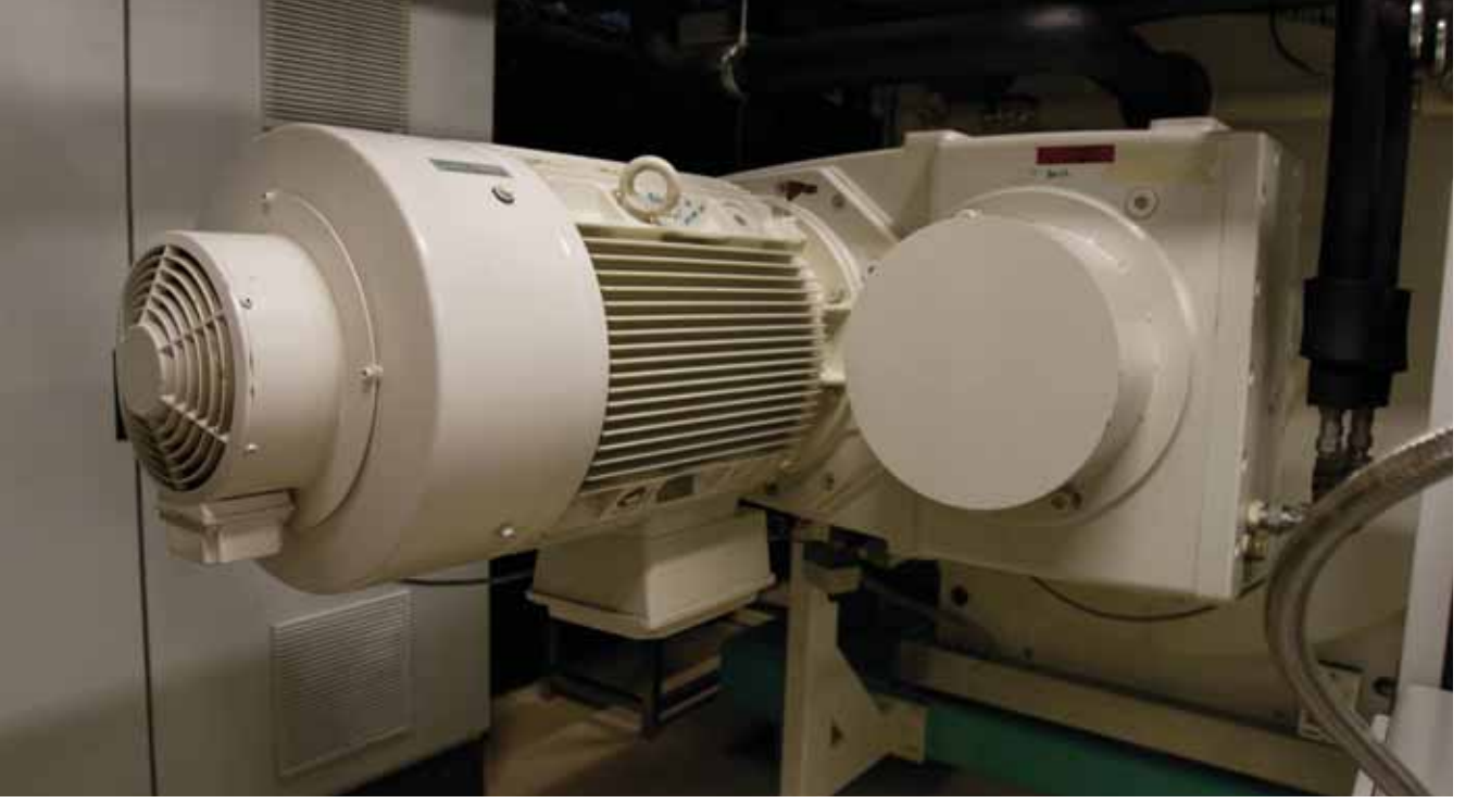
Konçlama makinesini tahrik eden paralel milli motorlu redüktör
