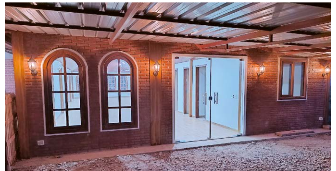
Anbau auf dem Missionsgelände für den geplanten Bibelunterricht
