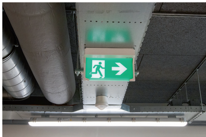
D-Sign armatuur met geïntegreerde vluchtrouteaanduiding.
