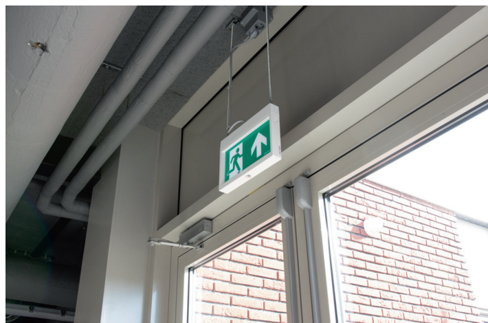
Famostar Go! armatuur met geïntegreerde vluchtrouteaanduiding.
