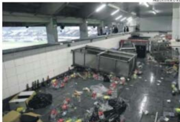
Um dos bares do Estádio D. Afonso Henriques ficou completamente destruído
